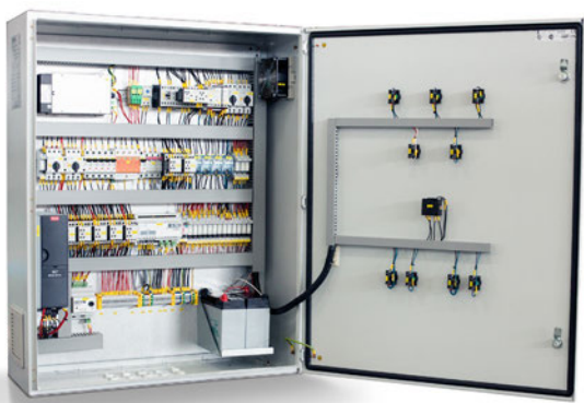
Zdjęcie 2. Przykładowy widok wnętrza zasilacza, w którym wykorzystano przetwornicę częstotliwości.
