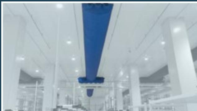
Diese Kreisabschnitte werden häufig in hohen Speicher und Serverräumen verwendet und benötigen sehr wenig Platz um den idealen Luftstrom zu kreieren. Wenn diese mit Richtungswürfen entworfen werden, sorgen diese Kanalformen für eine ausgezeichnete Mischung und eine gleichmäßige Luftverteilung ungeachtet ihrer schlanken Art.
