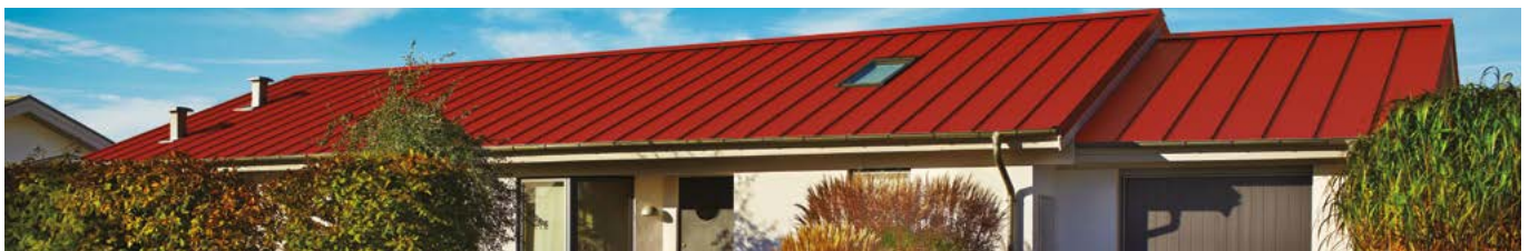
A – przykładowa szerokość efektywnego krycia 540 mm. Możliwość wykonania paneli od 160 mm.
